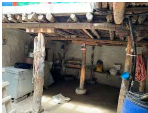
Erdgeschoss, wo früher Vorräte und Werkzeuge gelagert wurden
