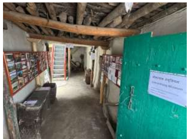
Blick durch die Eingangstür hinein ins Haus
